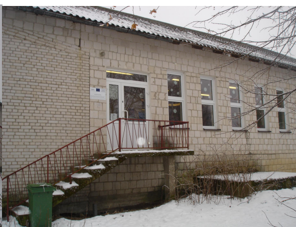
Fot.3 Wejście do ośrodka przedszkolnego
