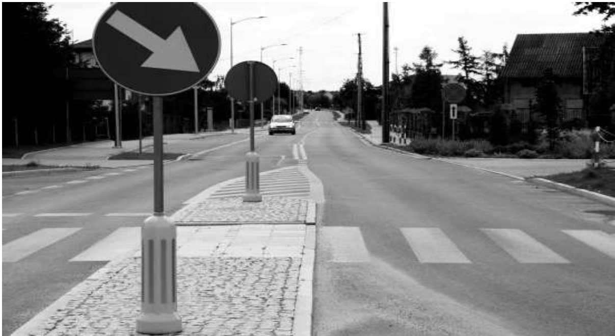
Rysunek 4. Zmodernizowana droga powiatowa nr 3234W Stara Wieś – Chorzele – Krasnosielc.
